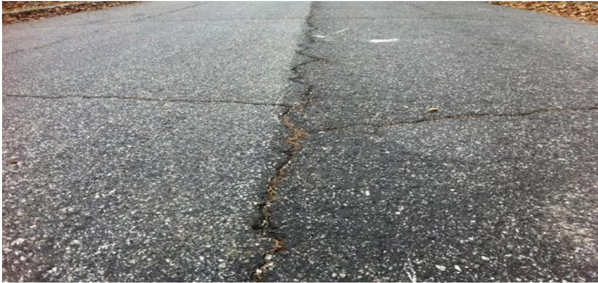
Longitudinal (Linear) Cracking
