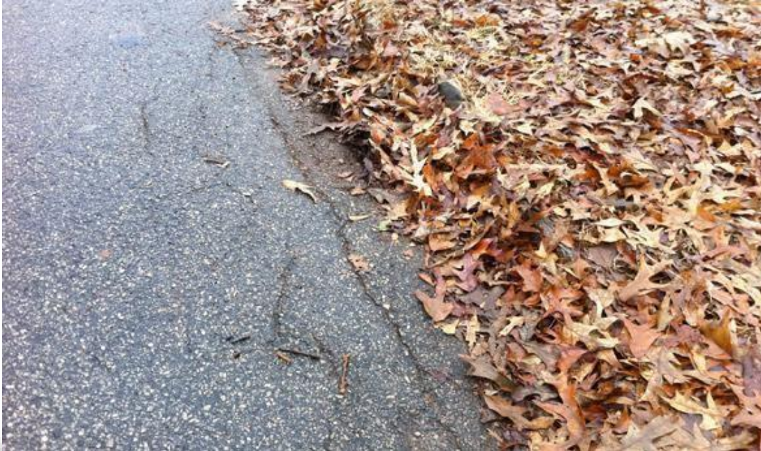
Fig. Edge Cracks
